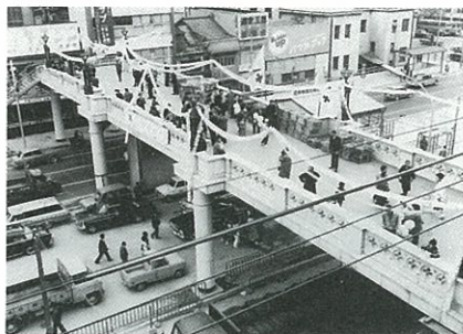
歩道橋となった心齋橋
