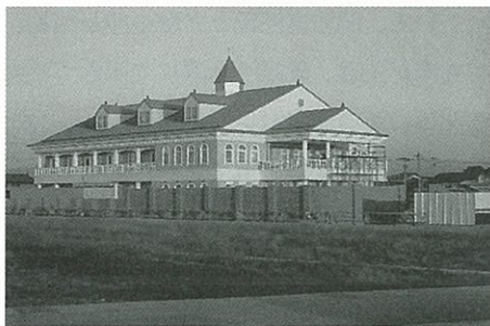
建設中の松井秀喜ベースボールミュージアム
