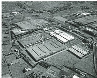
日本精工株式会社 埼玉工場全景
