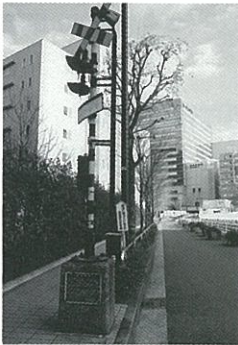
道端に立つ踏切警報機
