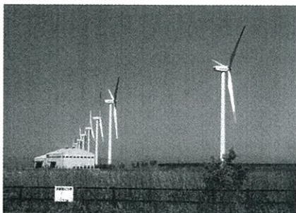
北九州エコタウン内にある風力発電
